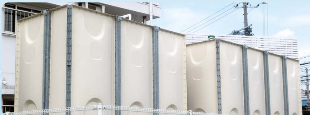
サンカットシステム施工例
