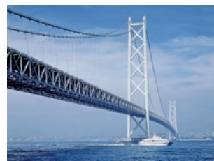
明石海峡大橋
