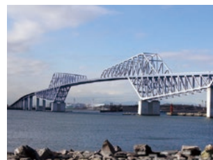
東京ゲートブリッジ
