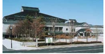
青森県立武道館 地下外壁、相隣地床 B-2 C-1 工法
