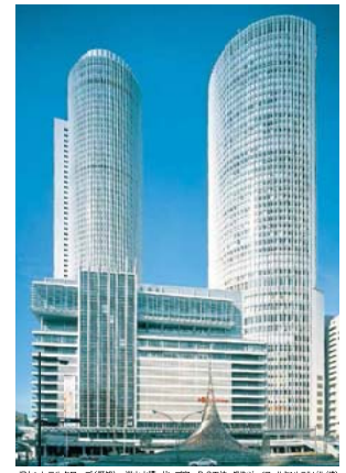
JFセントラルタワー（愛知） 消火水構、ポンプ室 B-2工法 南シティ・パールセントラルビル（株）
