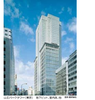
山王パークタワー（東京） 地下ピット、室内床、他 B-2 B-3 B-6 Q A-2工法 設計 豊田建設
