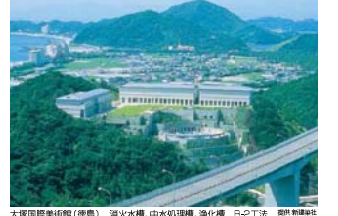
大塚国際美術館（徳島） 消火水構、中水処理槽、浄化槽 B-2工法 設計 豊田建設
