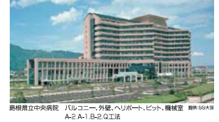
豊根県立中央病院 バルコニー、外壁、ヘリポート、ピット、機庫室 設計 S&A社 A-2 A-1 B-2 Q工法
