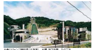
大倉山ジャンプ競技場（北海道） 水構、地下外壁 B-2工法
