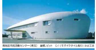
南地区市民活動センター（埼玉） 屋根、ピット C-1（モザイクタイル貼り）B-2工法
