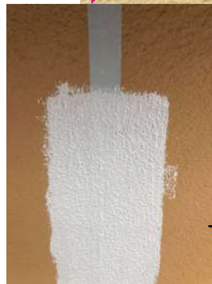
下塗り(プライマー)
