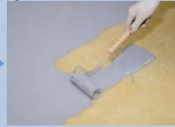
表層の凸部を研磨し、平滑にした後、タフシール#50に各種トナーを5%添加したものに硬化剤を混合し、塗りムラがないように均等に塗布してください。
