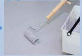
タフシールの各種トップコートに硬化剤を混合し、塗りムラがないように均等に塗布してください。
