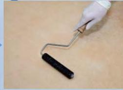
脱泡ローラーで、層内に泡が残らないように脱泡してください。
