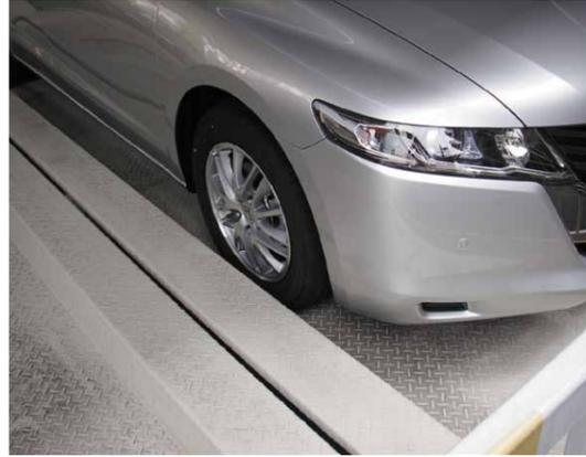
金属立駐機は屋内外を問わずに設置され、経年により腐食が進行します。また屋外では降雨等で床面が濡れていると滑りやすく、乗降時には転倒事故に繋がる場合もあります。ボウジンテックス#5500Nを用いた本仕様は耐久性と防滑性を兼ね備えたものです。
