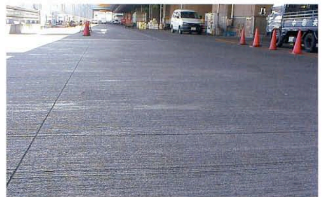
■ ハケ引きコンクリート
