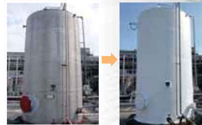
散水によりタンク内部の内液温度上昇を抑制 散水と同程度の温度抑制効果が得られた
