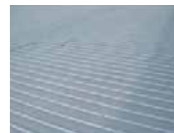
K社 工場 (折板屋根)
